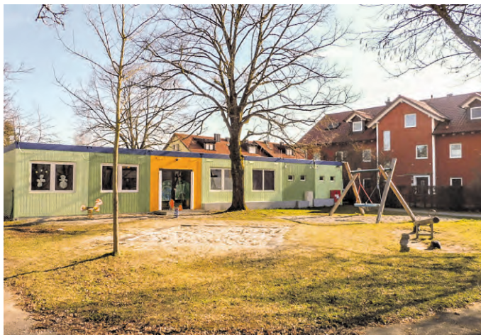
Noch stehen am Buchenauer Platz Container für den städtischen Kindergarten Villa Kunterbunt. Nach dessen Umzug an die Senserbergstraße entsteht hier die neue Krippe.
